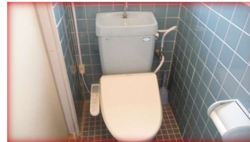
トイレ(温水洗浄便座完備)
